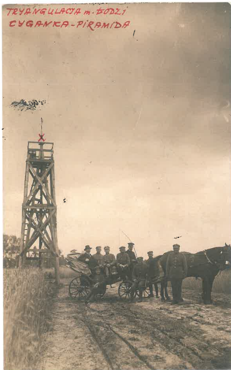
Podwójna wieża triangulacyjna nad punktem „C” – Cyganka. Franciszek Walicki podczas wizytacji pomiaru kątów, wykonywanych przez oficerów z kursów mierniczych Instytutu Wojskowo-Geograficznego
