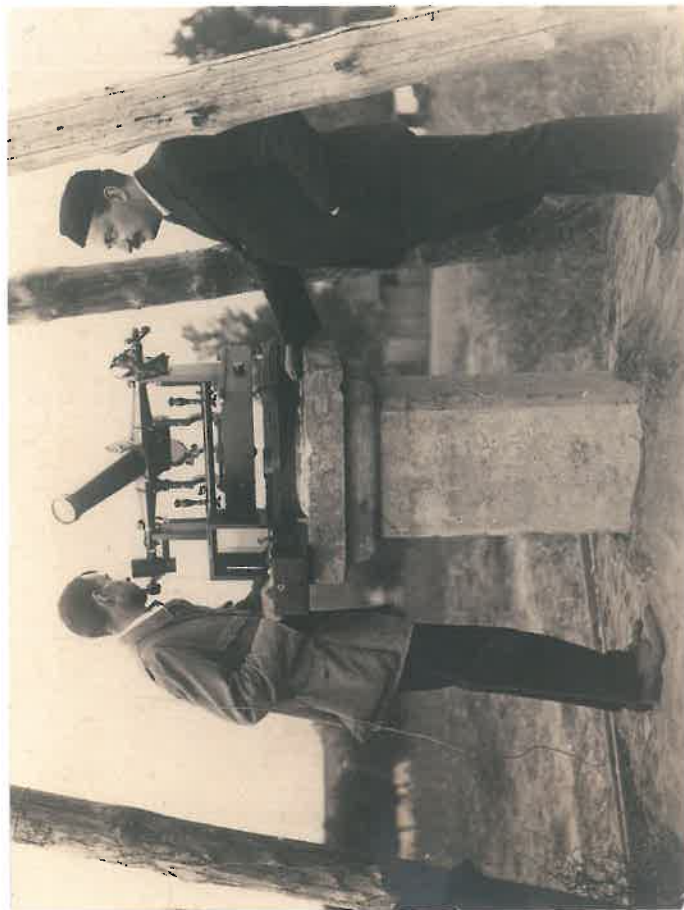
Profesor Tadeusz Banachiewicz (po prawej) i jego asystent Józef Witkowski na punkcie „R” na Retkini w dniu 10 sierpnia 1921 r. Instrument widoczny na fotografii to narzędzie pasażowe firmy Starke & Kammerer w Wiedniu, z lunetą łamaną w środku, o średnicy obiektywu 68 mm, służące do obserwacji astronomicznych
