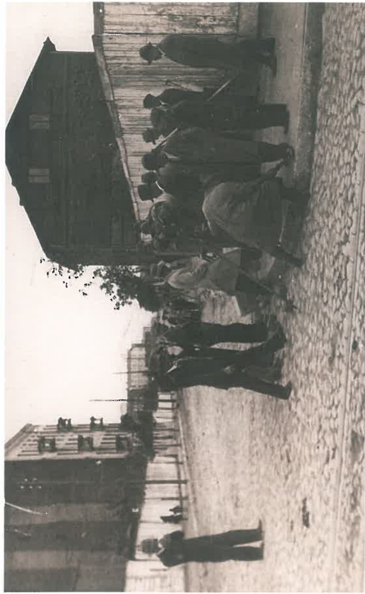
Wrzesień 1933 r. Początek pomiaru drutami inwarowymi długości bazy sieci triangulacyjnej na ul. Zagajnikowej, od punktu „Bn”, położonego na skrzyżowaniu z ul. Średnią
