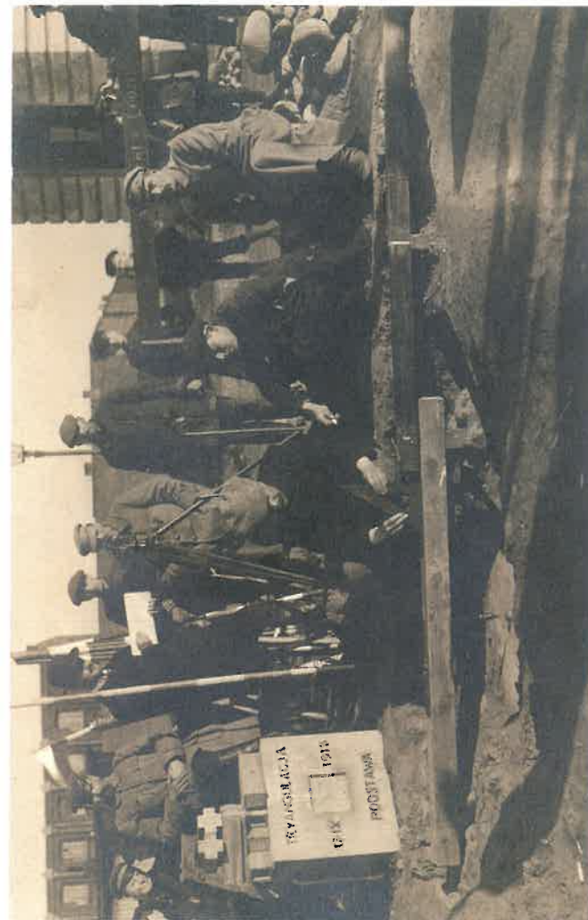
Ostatnie czynności przy pomiarze bazy w dniu 17 listopada 1918 r. na północnym punkcie krańcowym „Br” na skrzyżowaniu ulic Zagajnikowej i Średniej (Pomorskiej). Obserwacje prowadził inż. Wacław Bobrowski, po lewej (w kapeluszu) z dziennikiem w ręku, technik Włodzimierz Jastrzębski. Z boku widoczna betonowa pokrywa znaku z napisem „TRYANGULACJA – 17 IX 1918 – PODSTAWA”
