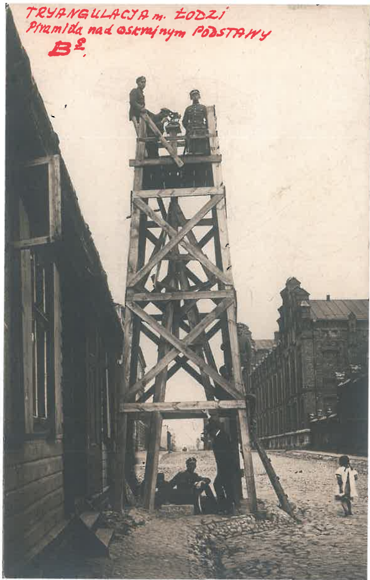
Obserwacje kątowe wykonane latem 1919 r. na punkcie krańcowym bazy „Bs”, zabudowanym drewnianą wieżą, położonym na ul. Zagajnikowej (Kopcińskiego), niedaleko skrzyżowania z ul. Rokicińską (aleją Piłsudskiego), w tle widać Monopol Łódzki
