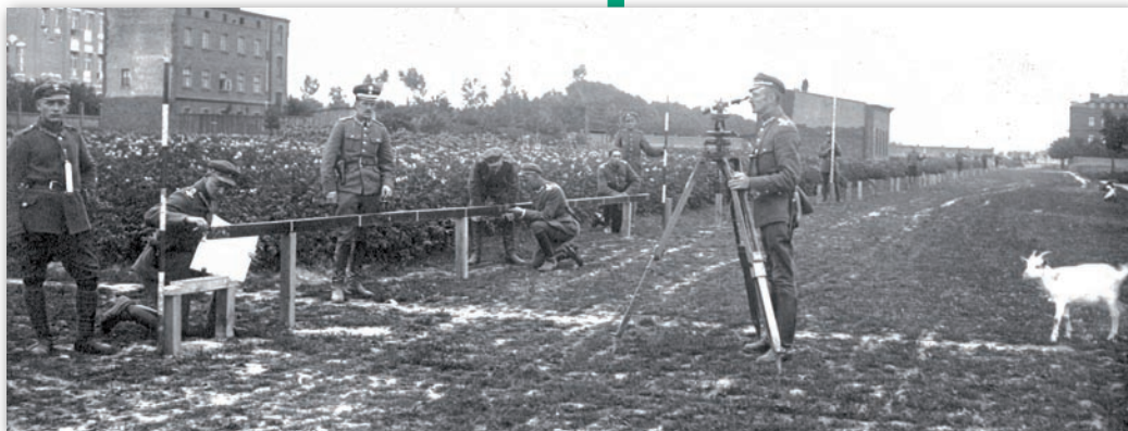
Oficerowie z kursów mierniczych Instytutu Wojskowo-Geograficznego przy pomiarze długości ciągu poligonowego drewnianymi łatami na ul. Jana w 1921 r.
