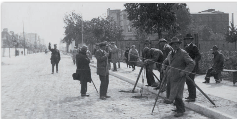
Początek pomiaru drutami inwarowymi długości bazy sieci triangulacyjnej w ul. Zagajnikowej (Kopcińskiego) od punktu „Bn” położonego na skrzyżowaniu z ul. Pomorską
