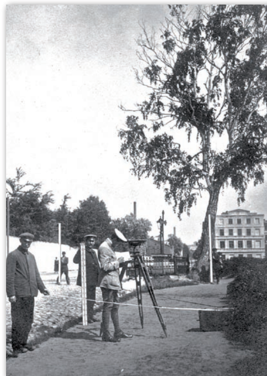
Niwelacja precyzyjna m. Łodzi wykonywana w lecie 1919 r. Widoczny niwelator firmy Bamberg z lunetą o długości 45 cm oraz używane do pomiarów łaty rewersyjne firm Bamberg i Gerlach o długości odpowiednio 3 m i 1,5 m
