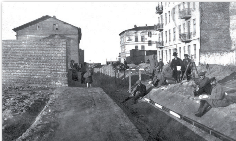
Pomiar długości podstawy (bazy) łódzkiej sieci triangulacyjnej w listopadzie 1918 r.; dokładnie widoczne są drewniane fały miernicze, leżące na drewnianych palach usytuowanych w dwóch poziomach
