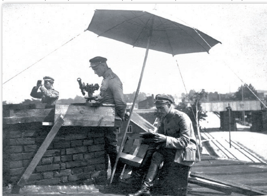
Pomiar kątów łódzkiej sieci triangulacyjnej latem 1919 r. Oficerowie z kursów mierniczych na punkcie „Ps”, usytuowanym na dachu domu przy ul. Pabianickiej, za wiaduktem kolejowym
