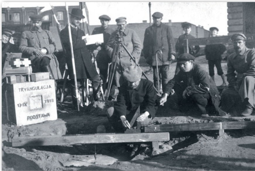
Ostatnie czynności przy pomiarze bazy 7 listopada 1918 r. na punkcie „Bn”. Obserwacje prowadzi inż. Bobrowski, po lewej (w kapeluszu) z dziennikiem w ręku – technik Jastrzębski. Doskonale widoczna betonowa pokrywa znaku z napisem: TRYANGULACJA - 17 IX 1918 - PODSTAWA
