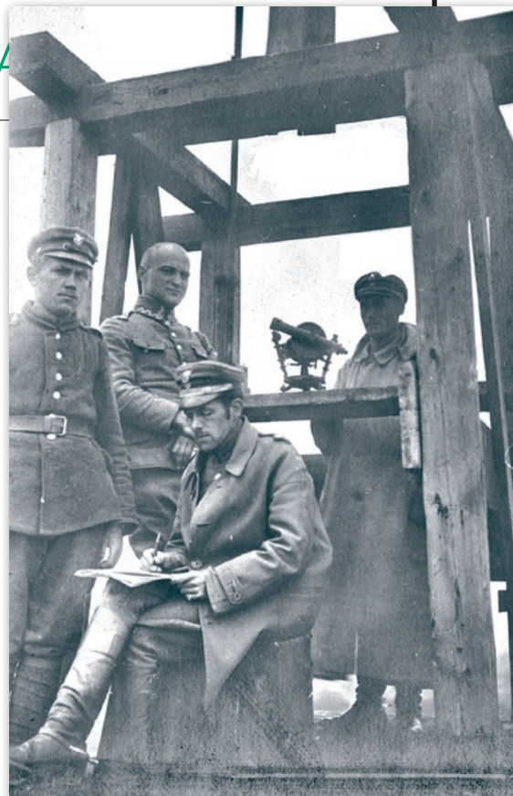
Stanowisko teodolitu na będącej w budowie wieży kościoła św. Stanisława Koski, podczas pomiaru kątów sieci triangulacyjnej w 1919 r.
