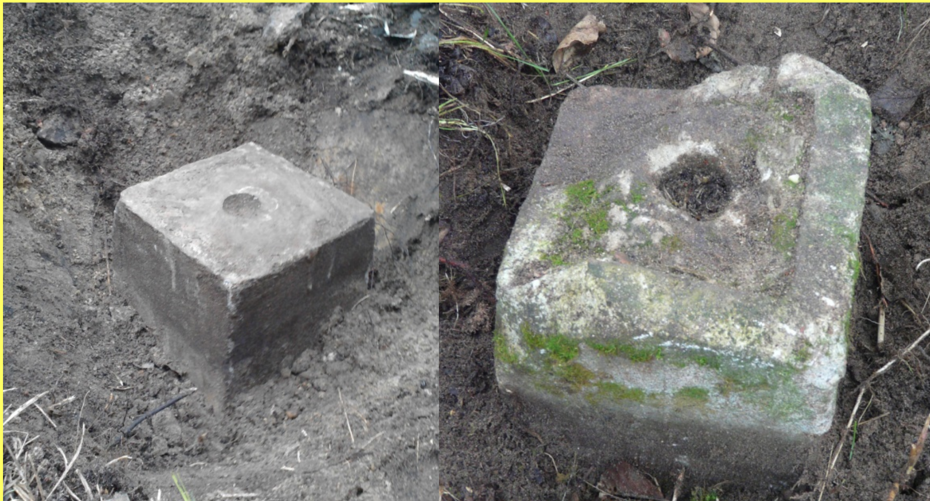
Rys. 18. Punkty osnowy po byłej kolejce wąskotorowej (fot. autora)
