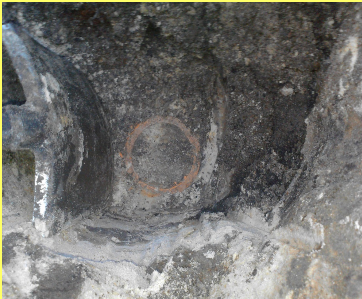
Rys. 19. Odszukany punkt nr 122k. Podcentr to rurka drenarska (fot. autora ).
